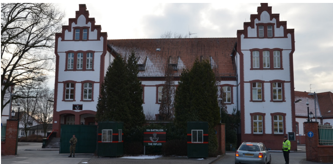
Abb. 2 Block 1 Alanbrooke Kaserne, Ansicht Hauptzufahrt
