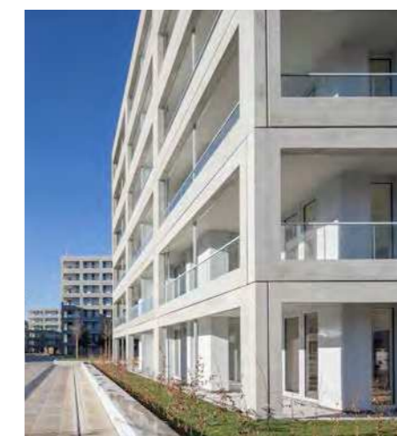
Abb. 1 Umlaufende private Freiräume von Luftbalken umrahmt – Die neue Gerberau, München; Goetz Castorph Architekten
