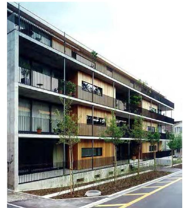
Abb. 1 Laubengang als gemeinschaftlicher Außenraum mit privaten Nischen – Mehrfamilienhaus Hinterbergstraße, Zürich (CH); Gret Loewensberg und Alfred Pfister Architekten
