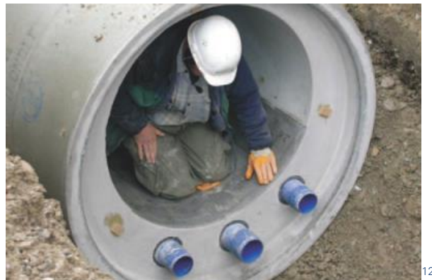
Abbildung 16 Tauscherelemente in DN 3000 und Sonderausführung DN 800
