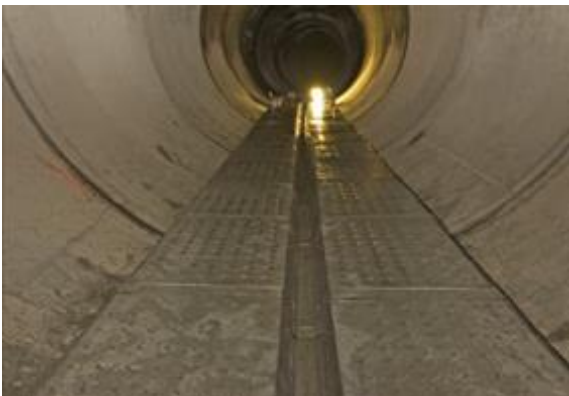
Abbildung 16 Tauscherelemente in DN 3000 und Sonderausführung DN 800
